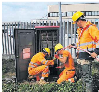
La posa della fibra di Tim
